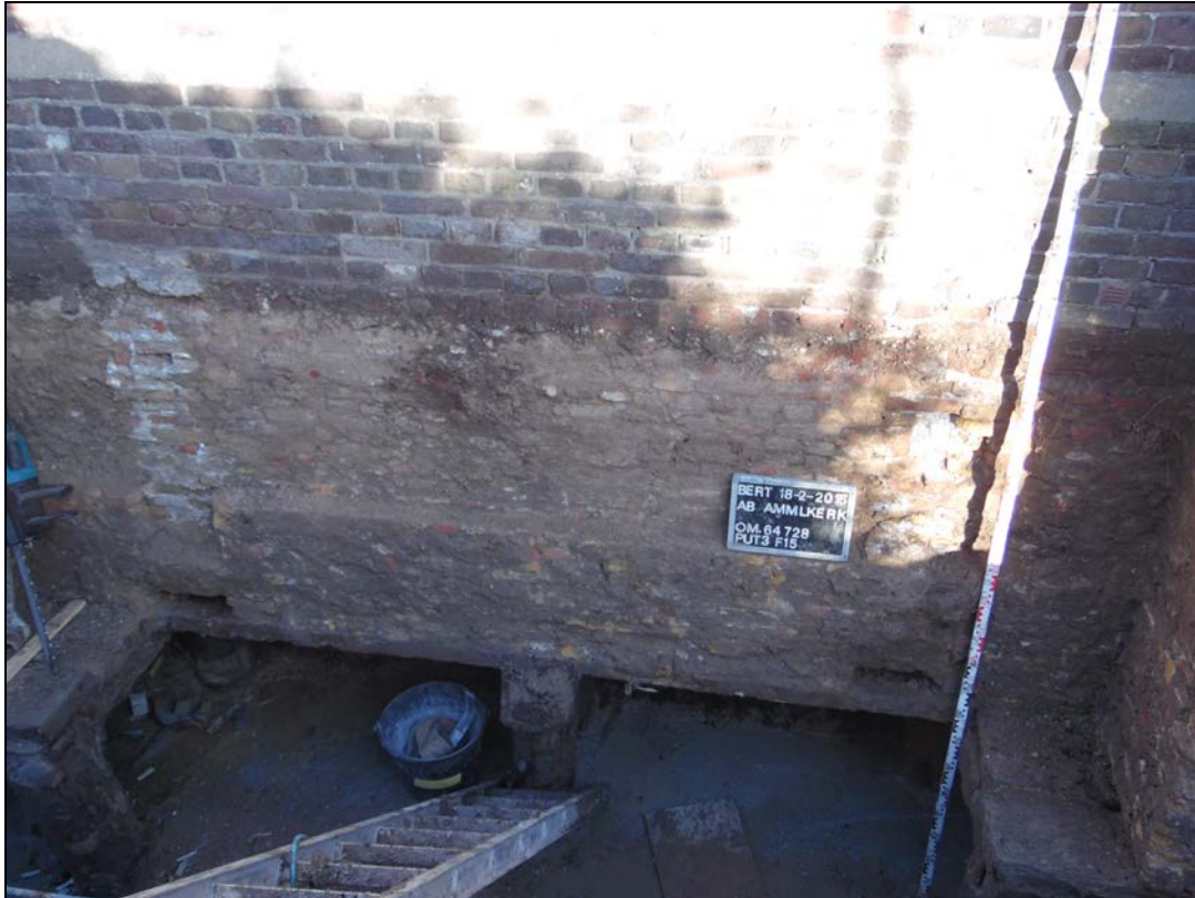
Afbeelding 32. Zijingang, Spoor nr. 5. De afdrukken van het muurwerk zijn nog zichtbaar.
